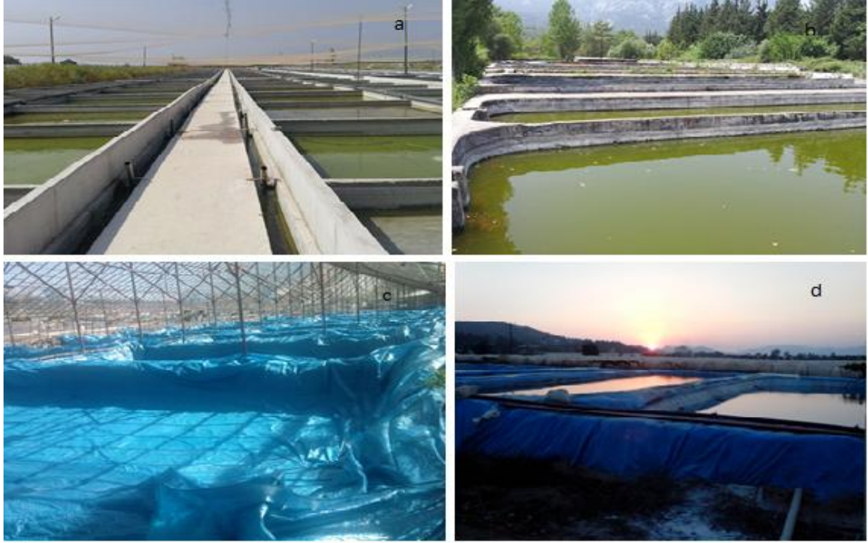
Şekil 1. Antalya bölgesindeki süs balığı işletmelerinin havuz tipleri a: Akdeniz su ürünleri üretme enstitüsü, b: Sığ beton havuzlar, c: Plastik kaplamalı toprak havuzlar, d: Sera havuzları
